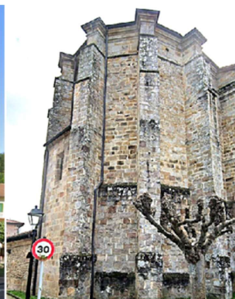
2 Y su cabecera poligonal con contrafuertes escalonados.
