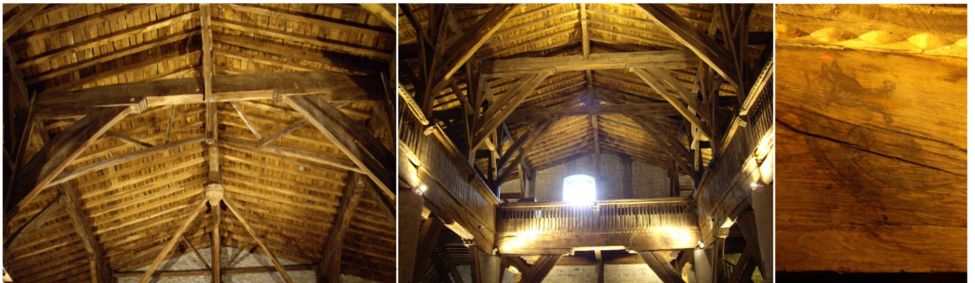
❶ Entramado de la nave. Estas cubiertas fueron restauradas en los años 70 del siglo pasado. ❷ Y la parte del coro y los dos brazos laterales de sus galerías. ❸ Detalle de una alegoría grabada en sus vigas.
