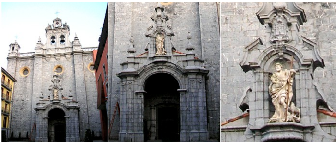
❶ Fachada con tres calles separadas por gruesas columnas rectas adosadas capada paño está abierto por un óculo. ❷ En la parte central su puerta adelantada de medio punto y remata una espadaña con dos vanos. A sus lados una balustrada con pequeñas torrecillas en sus ángulos. ❸ En la hornacina se encuentra la talla de San Juan Bautista, que es el patrono de la localidad.
