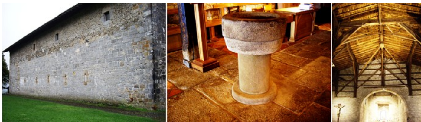
❶ Lateral exterior del lado del Evangelio. ❷ Pila bautismal de piedra lisas sin pulir cilíndrica con un rebaje en su parte inferior sobre un fuste redondo y basa igualmente redonda. ❸ Detalle del entramado de su artesanado en la zona de su cabecera.
