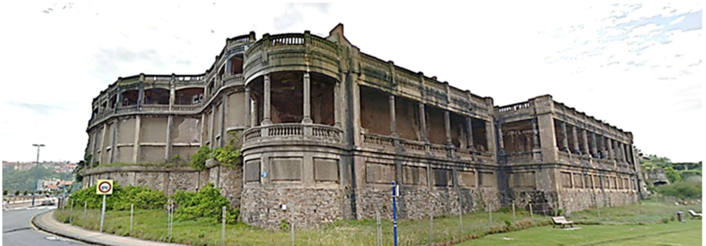
1 Galerías Punta Begoña, construidas como remate del acantilado de Arriluce en Guecho. Se encuentran muy deteriorados por la fuerte exposición marina y por la falta de mantenimiento. Se prevé por los carteles una actuación urbanística.
