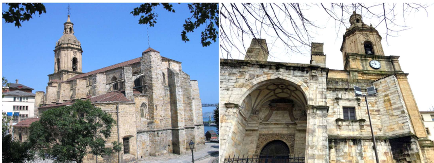
① Parte posterior de templo con su cabecera poligonal y gruesos contrafuertes que en los laterales se convierten en arbotantes Foto Luidger. ② Puerta lateral de la Ribera cobijada bajo un gran arco con cierta profundidad. En esta portada se manifiesta el renacimiento.
