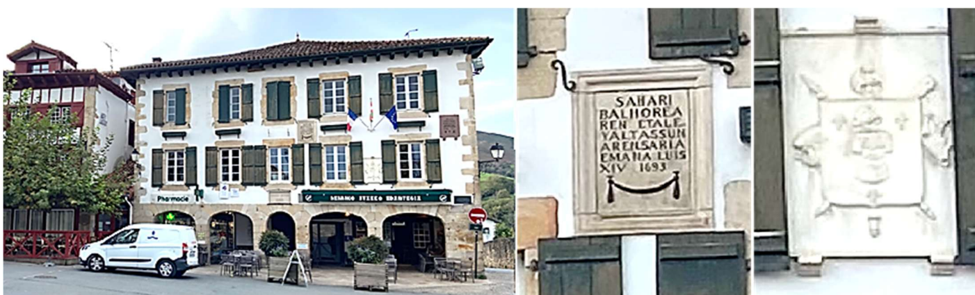
❶ Este edificio consistorial posee tres plantas con la baja abierto como pórtico con cinco arcos. ❷ SAHARI BALHOREAREN ETALE YALTASSUN ARENSARIA EMA HA LUIS XIV 1693. ❸ Y en el piso inferior también entre las ventanas este escudo posiblemente local. En campo de azul, una coraza de plata, surmontado de un casco del mismo metal, puestos entre tres flores de lis de oro, bien ordenados.
