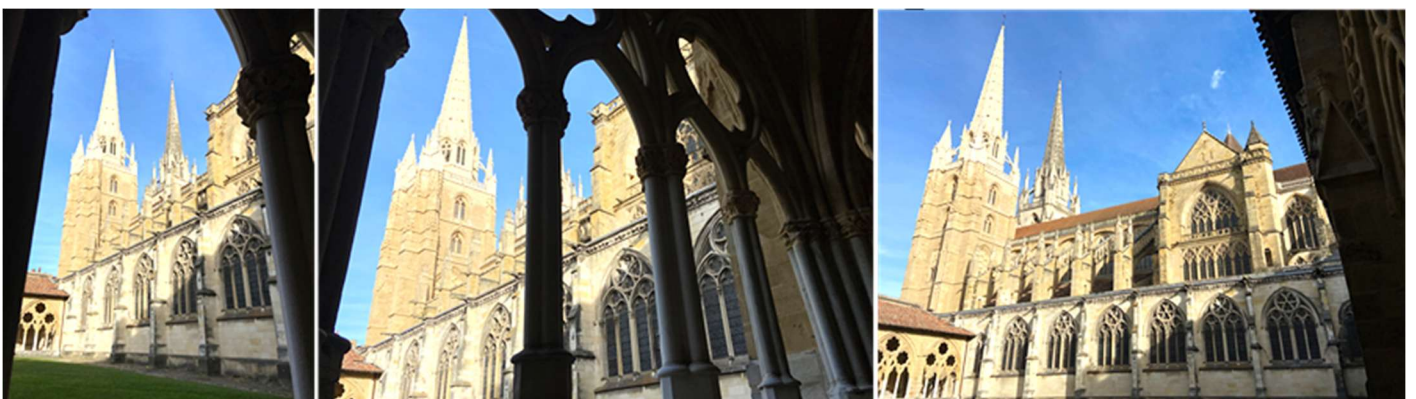
1 La panda norte del claustro que estaba adosada al templo. 2 Vista de la torre desde el panda este. 3 Lateral sur del templo, es el que no posee panda del claustro.
