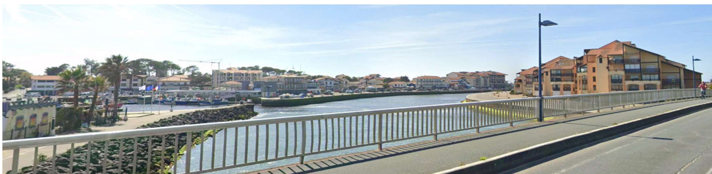
① Puente que cruza el canal de Hossegor y continua por la avenida de Notre Dame.
