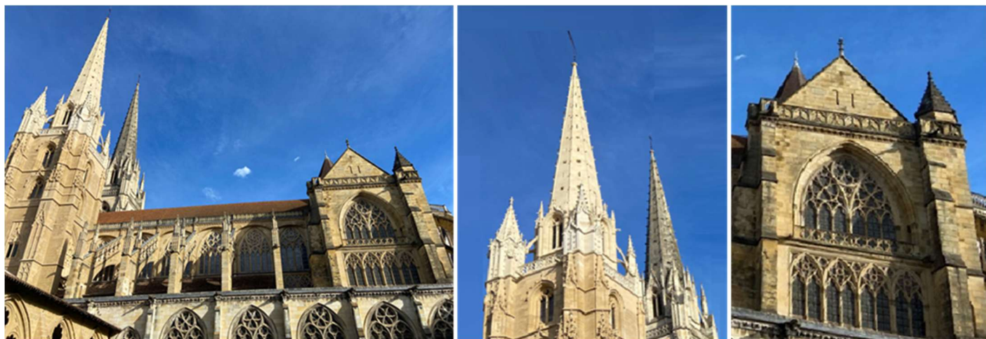
1 Lateral sur del Evangelio. 2 Detalle de la aguja de este campanario. 3 Parte exterior y ventanales del brazo del crucero.
