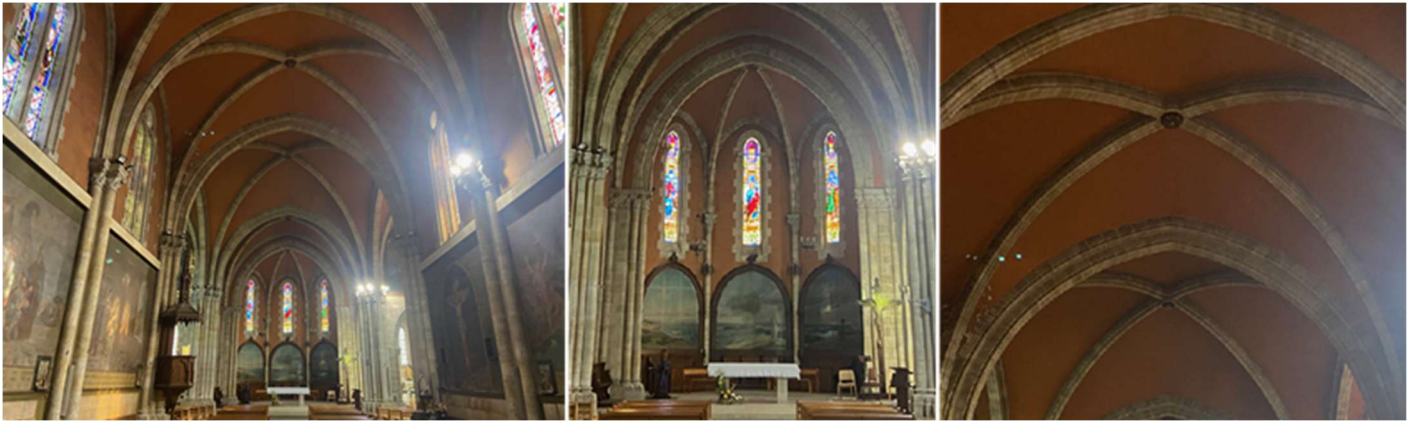
❶ Interior del templo con una nave de 43m ❷ Su cabecera poligonal, dotada con tres arcos que albergan pinturas y encima los tres ventanales con vidrieras de Gustave Pierre Dagrant. ❸ Sus bóvedas con crucería simple y claves.
