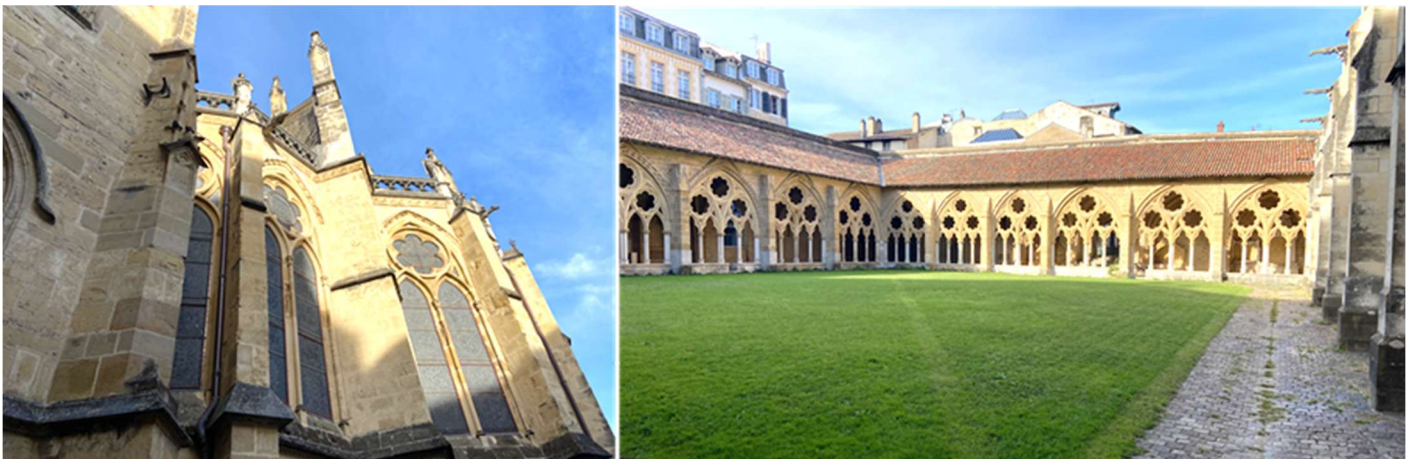
1 Lateral exterior del lado de la Epístola. 2 Los lados Sur y este del claustro con grandes arcos apuntados En la puerta del brazo izquierdo del crucero puede verse un bonito llamador cincelado (s. XIII) conocido con el nombre de "anilla de asilo"
